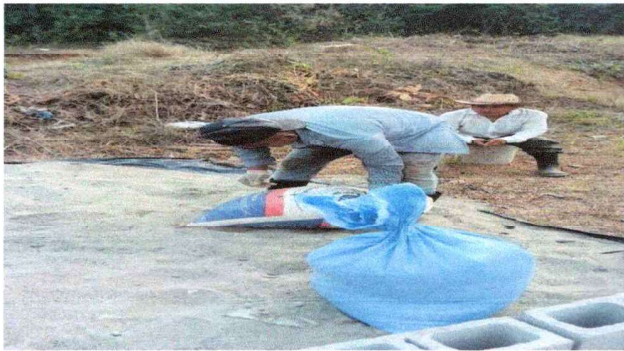
Foto1: se observa en la fotografia durante la ejecucion de la circulacion del predio escolar.
